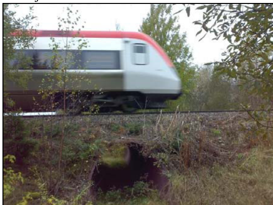
Kotunnel i Skedlo är för låg och hästarna skräms av tåget. Se öppning under järnvägen.
